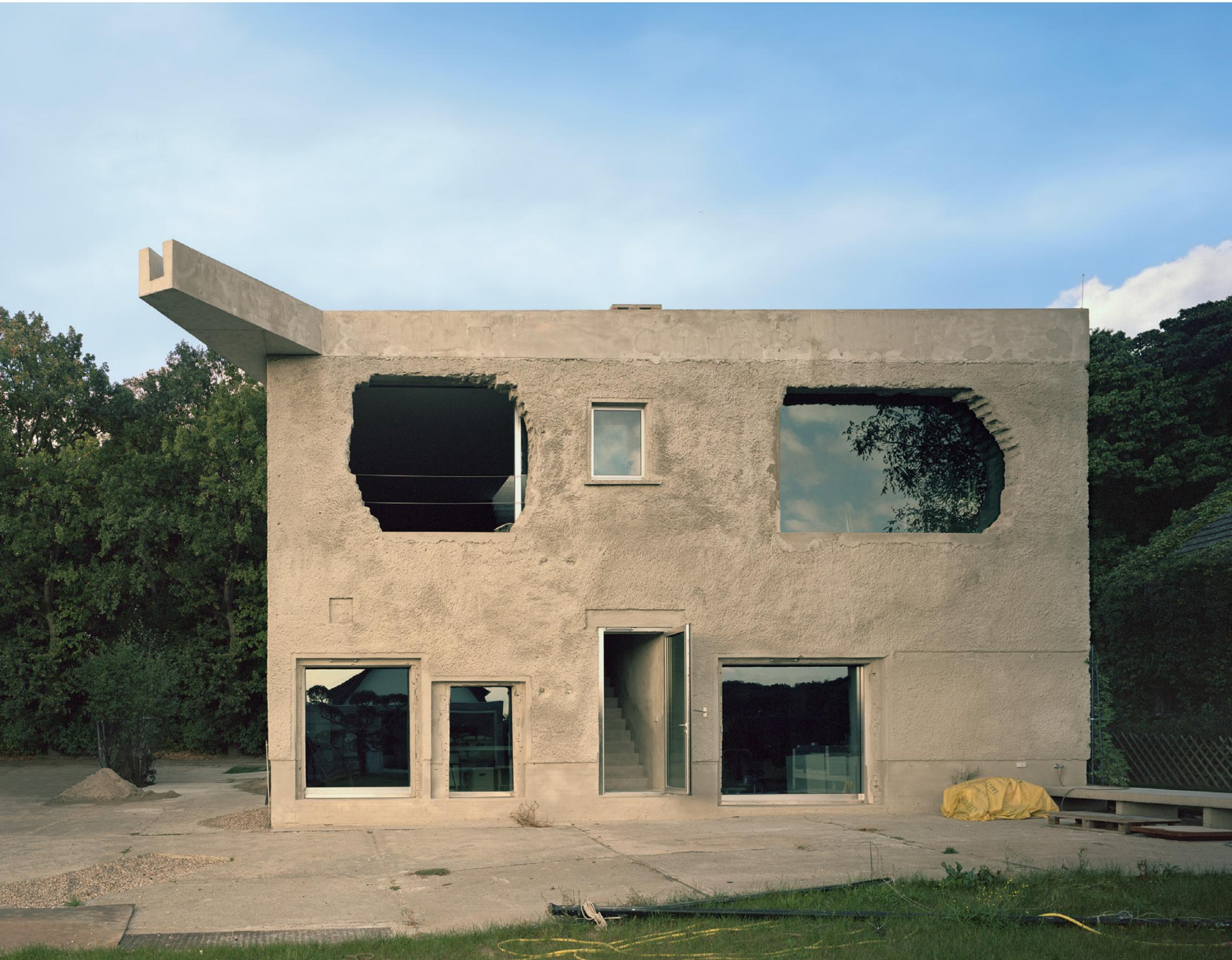
Diese ehemalige Trikotagenfabrik in Potsdam ist eine schroffe, kastenförmige Struktur mit zerklüfteten Fensteröffnungen, die heute ihr Architekt Arno Brandlhuber nutzt. Ein mittig hinzugefügter Betonkern stützt das neue Dach, das die – von Brandlhubs Freunden eigenhändig geschlagenen – großen Durchbrüche ermöglichte, die den Blick auf See und Wald freigeben.
